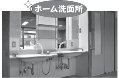
体格、車いす座面の高さを考慮し2台の手洗いを設置しました。洗面ボールの深さ、蛇口・カラン位置も調整されています。
